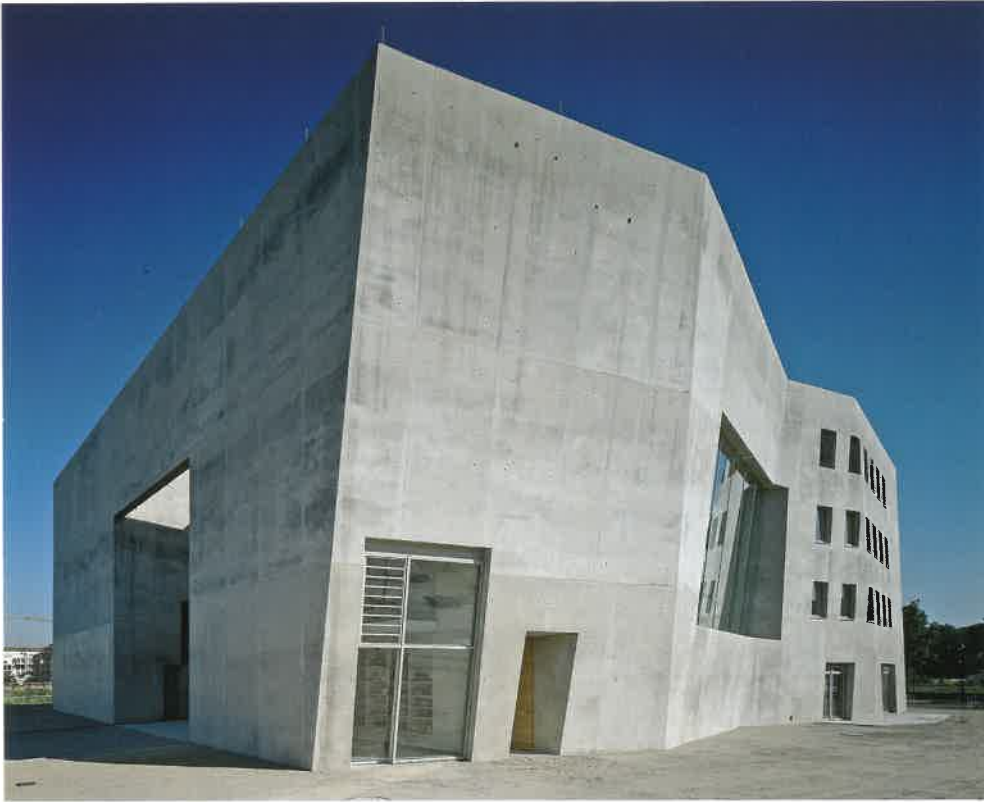
1 Architekten Kister – Scheithauer (2004): Ökumenische Gemeindezentrum, Maria Magdalena, Groß in Freiburg
