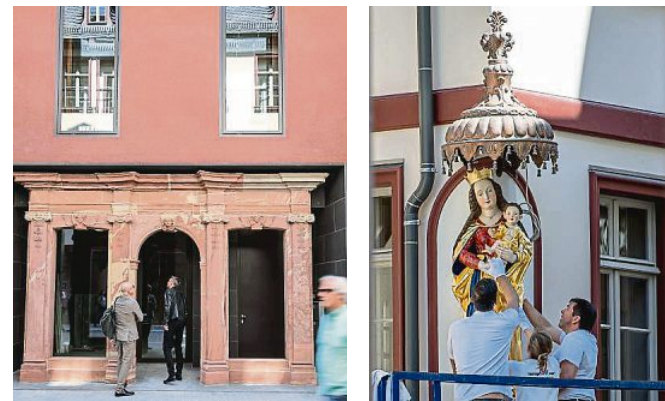
Reizvolle Gegensätze von alten und neuen Fassaden. Letzte Arbeiten an einer Marienstatue.
